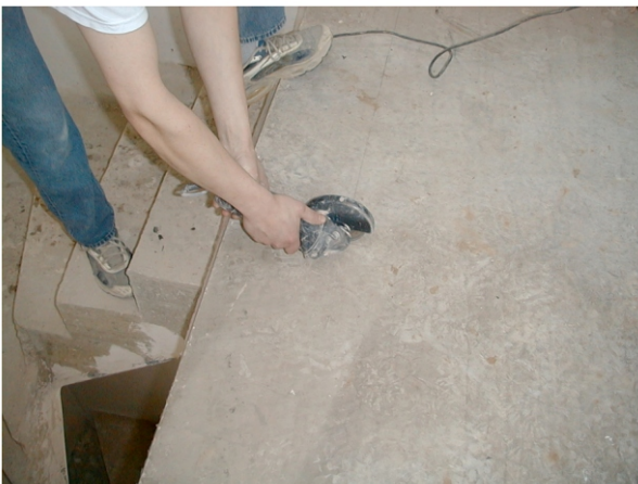
Bild 03: Bis Stossvorderkante verlegter Estrich in Stufenbreite ausschneiden, da unbedingt eine Trennung zwischen schwimmend verlegten Estrich und Stufenverbundestrich erfolgen muss.
