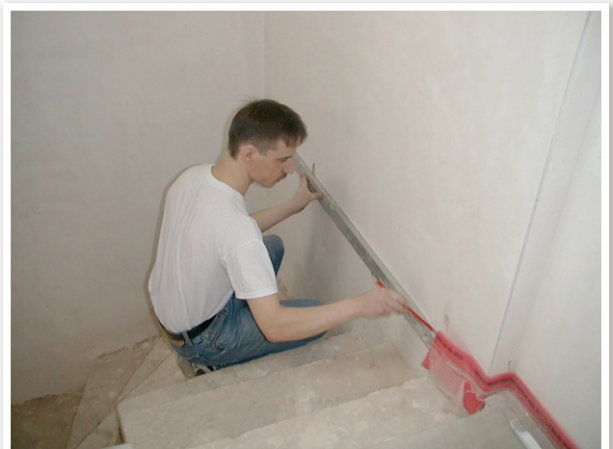
Bild 06: Anzeichnen der Gesamthöhe unter Berücksichtigung der oben und unten verlegte evtl. Verschiedener Belagstärken.
