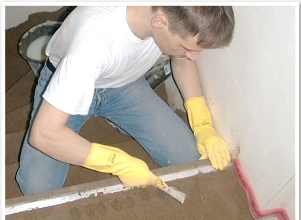
Bild 30: Profil mit leichten Hammerschlägen unterfüttern.
