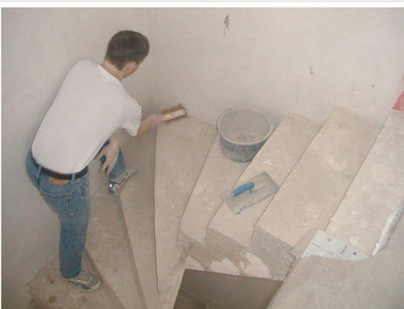
Bild 05: Treppe gründlich reinigen.
