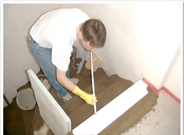
Bild 18: Stufenbrett im rechten Winkel zur Wand mit ca. 2 cm Überstand anlegen. Winkelberechnung: Wand 60 cm, Stoss 80 cm = 1,00 m.
