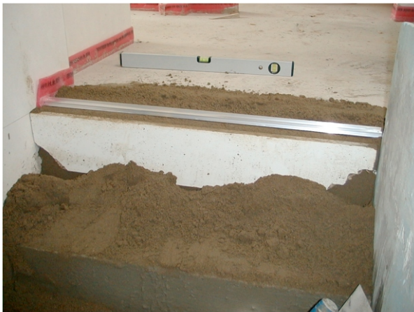
Bild 25: Brett am Stossestrich anliegend mit leichten Hammerschlägen waagrecht zum Meterriss ausrichten. Stufenauftritt mit Estrich auffüllen.
