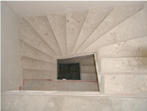
Bild 01: Rohbetonstufen.
