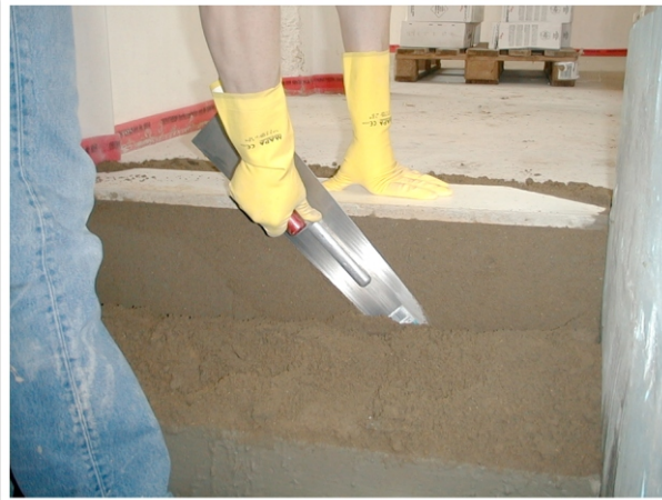
Bild 20: Estrich mit der Steinholzkelle am Stossbrett vorbei gerade abschneiden.
