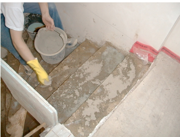
Bild 15: Zement aufstreuen.
