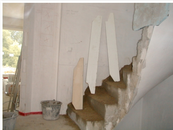
Bild 34: Schaldbretter für die verschiedenen Stufenlängen.
