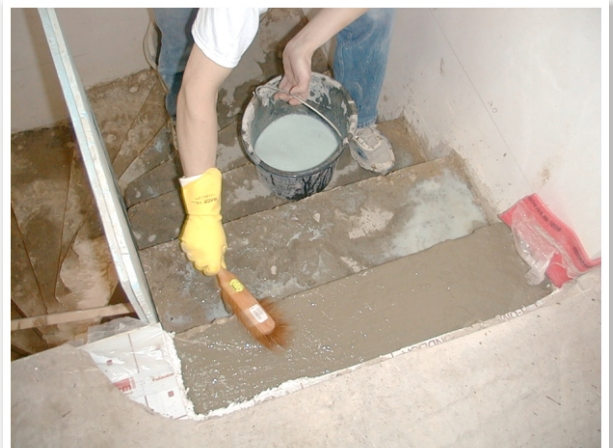
Bild 16: Stoss und Auftritt einschlämmen.
