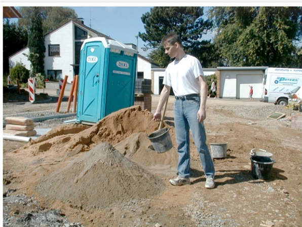
Bild 11: Mehrere Schaufeln Trockenmischung wie dargestellt nässen. Die Mischung sollte zur Verarbeitung erdfeucht sein.
