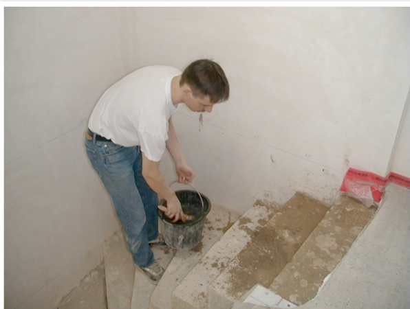
Bild09: Alle Stufen vornässen.
