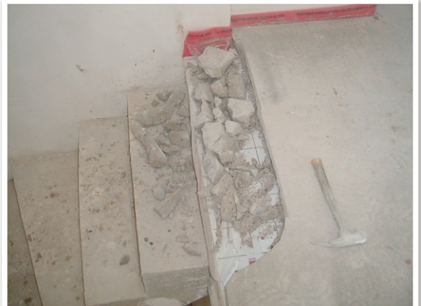
Bild 04: Dämmung in Stufenbreite entfernen.
