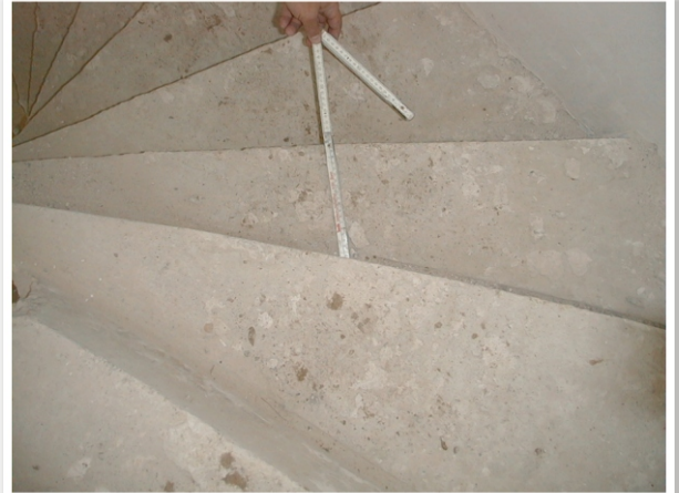
Bild 02: Differenzen in der Gehlinie zum späteren Ausgleich festhalten.
