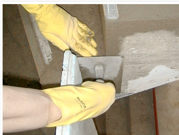
Bild 36: Stufenkopf anpassen.
