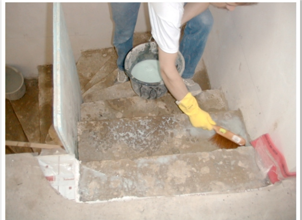
Bild 14: Wasser und Haftgrund (PCI oder ähnl.) 1:6 mischen. Max. 4-5 Stufen einnässen.
