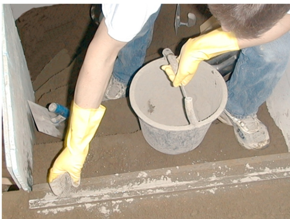
Bild 27: Profil und Estrichvorderkante mit Zement einpudern.
