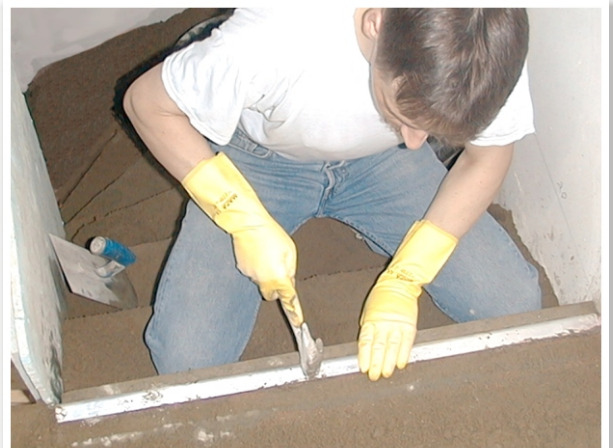
Bild 28: Profil in den nassen Estrich der Vorderkante mit leichten Schlägen einbringen. Vibrationen mit einer Hand dämpfen.
