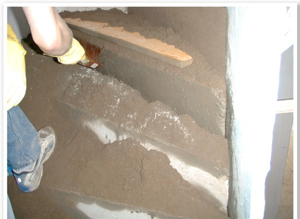
Bild 42: Stossfläche vor dem Estrichauftrag nachnässen.
