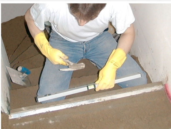
Bild 29: Kontrolle der Waagerechten.
