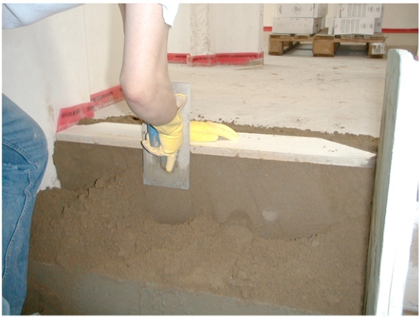
Bild 19: Vor dem Estrichauftrag Stossfläche nochmals nässen
