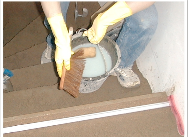
Bild 26: Treppenprofil (Alu 02 Unterteppich zum Schutz der Stufenvorderkante) rückseitig auflegen. Komplett einnässen einschl. der Estrichvorderkante.
