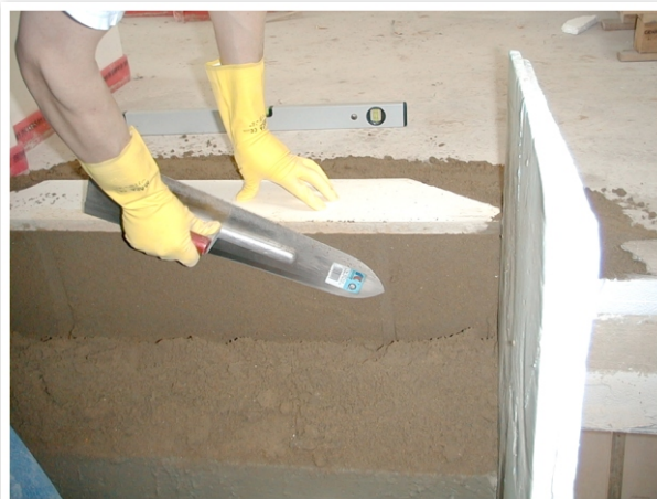
Bild 22: Evtl. Überstand abschneiden.
