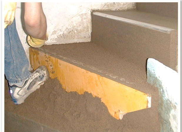
Bild 38: Vor dem Nässen Oberfläche mit Estrich gleichmäßig einstreuen. Nässen, abreiben und glätten.
