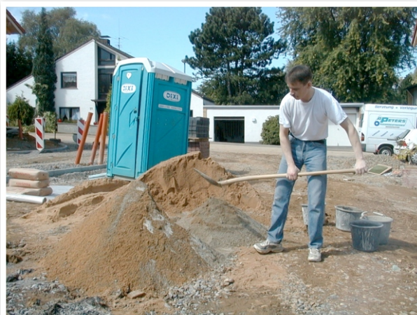
Bild 10: Mischvorgang: Sand 02 mit Zement im Verhältnis 1:3 mehrfach von Hand umsetzen. Oder mit Zwangsmischer arbeiten. Niemals einen Trommelmischer benutzen, da hier beim Anässen Klumpen entstehen.
