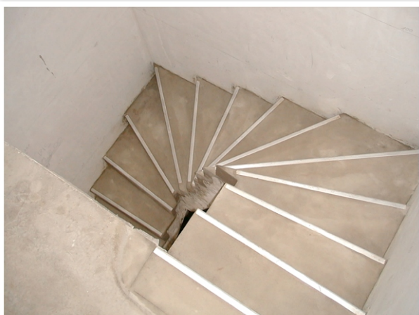
Bild 43: Hier ist ersichtlich, dass die Stufenauftrittsbreite in der Gehlinie gleichmäßig verläuft.
