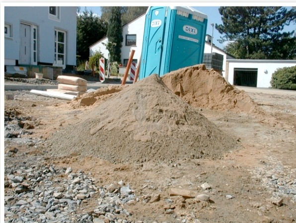
Bild 12: Mischung ca. 10 Min. ziehen lassen. Dann noch 2-3 mal umsetzen. Es sollte nicht mehr angesetzt werden, wie in einer Stunde verarbeitet werden kann.
