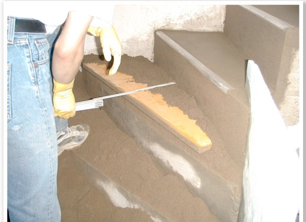
Bild 40: Immer die Gehlinie gleichmäßig einmessen.
