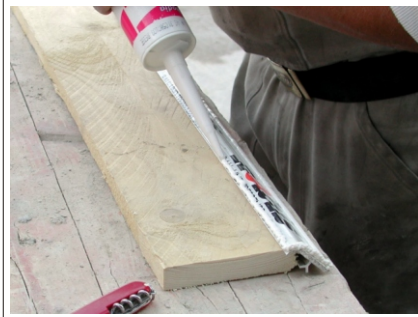
Bild 17: Wenn das Profil schräg an ein Brett gelegt wird, kann man den Kleber leichter auf die gerundete Profilverkante auftragen.
