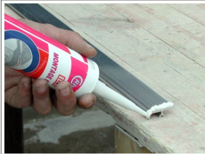
Bild 02: Elch Montagekleber kopfseitig auf das blanke Profil auftragen, damit kein Beton in die Rillen eindringen kann.
