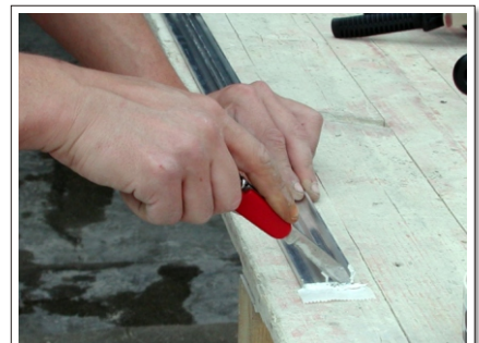
Bild 12: Überstehendes Tesaband an den Profilenenden sauber abschneiden.
