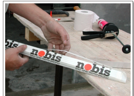
Bild 09: Abgeschertes Tesaband entfernen.
