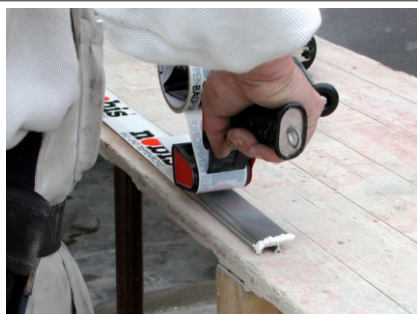
Bild 04: Profil mit Abroller abkleben.
