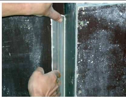
Bild 19: Profil gut in die Form einpressen. Jede Einpassung einzeln fertigen und ausgetretenen Kleber entfernen, um ein sauberes Ergebnis zu erzielen.
