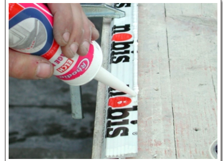
Bild 15: Elchkleber umlaufend am Profilrand auftragen.
