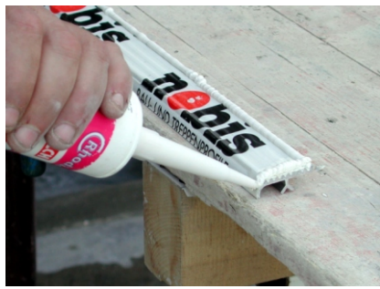
Bild 16: Elchkleber umlaufend auftragen.
