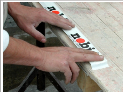
Bild 05: Elchkleber unter der Abklebung glatt streichen.
