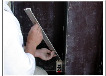
Bild 18: Profil in die Form einlegen. Durch den Holzklötz erreicht man den richtigen Abstand zum Stufenrand.
