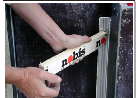
Bild 21: Das Anpressen ist unbedingt erforderlich, um einen bündigen Abschluss zur späteren Betonoberfläche zu gewährleisten.
