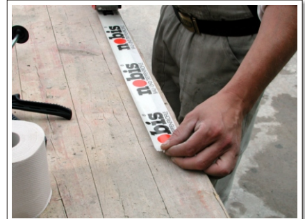
Bild 03: Profil mit Tesapackband 4124 abkleben. Bei diesem Band bleiben nach dem Entfernen auf dem Profil keine Kleberückstände.
